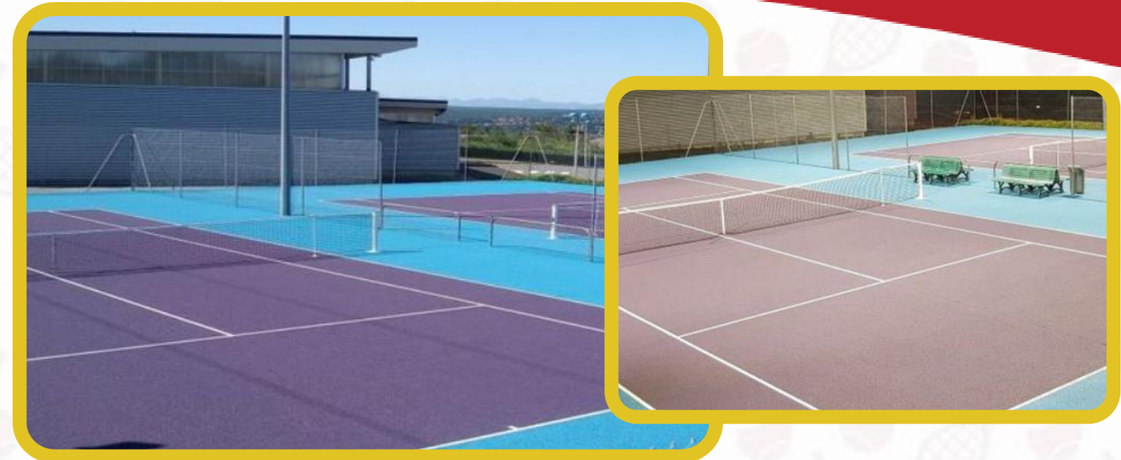
Deux courts extérieurs en béton poreux, entièrement rénovés. Ils sont éclairés à l'aide de projecteurs LED blancs.
